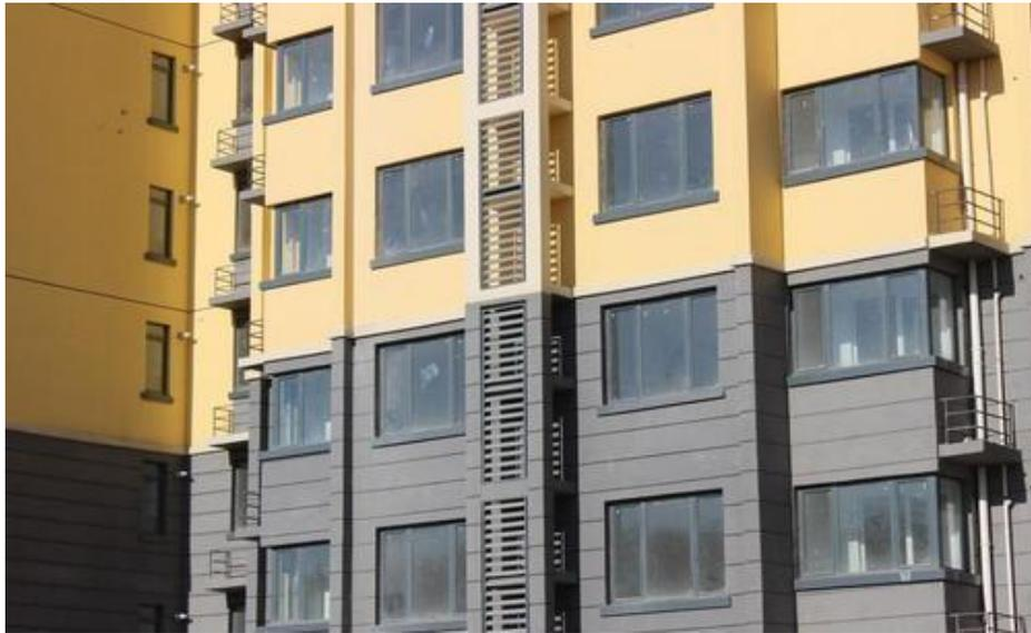
图 6.2.2 一体化设计的室外机机位
