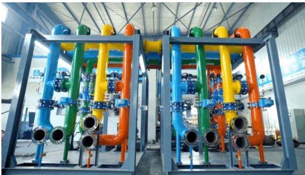
图 6.2.4-2 装配式制冷机房管道模块
