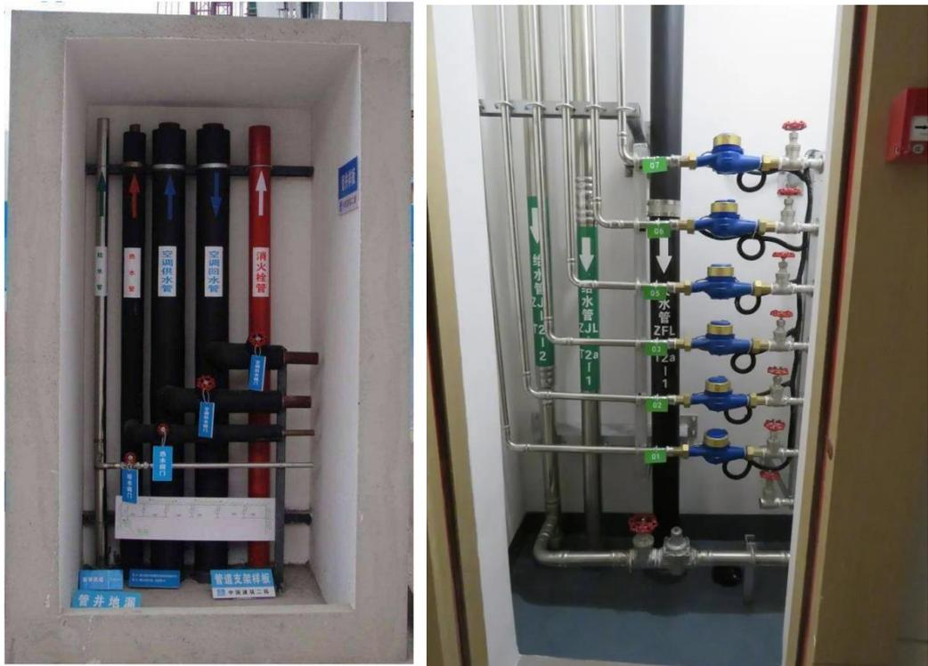
图 5.2.1 管线、阀门、水表集中布置
