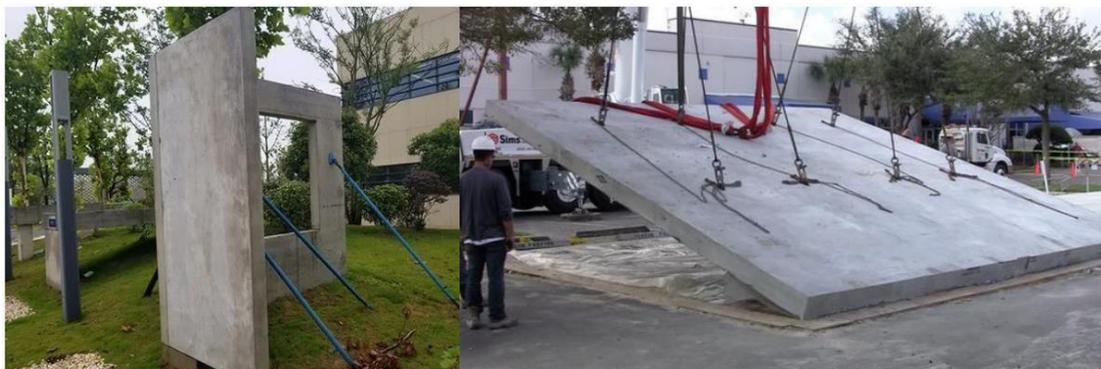
图 4.3.1-2 预制混凝土外墙板
