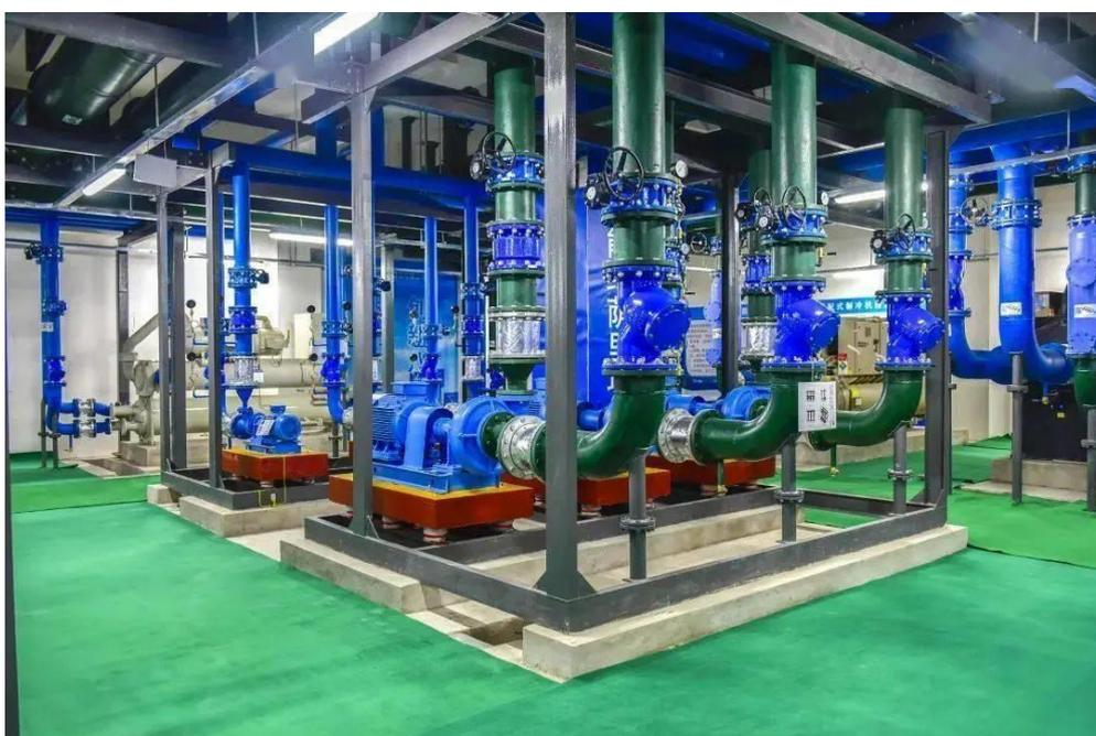
图 6.2.4-3 装配式制冷机房
