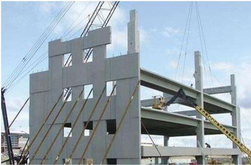
图1.1.1-1 装配式混凝土结构
