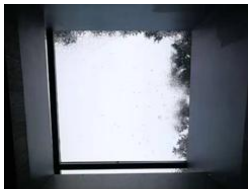
图 2.2.2-4 风雨连廊的玻璃顶
