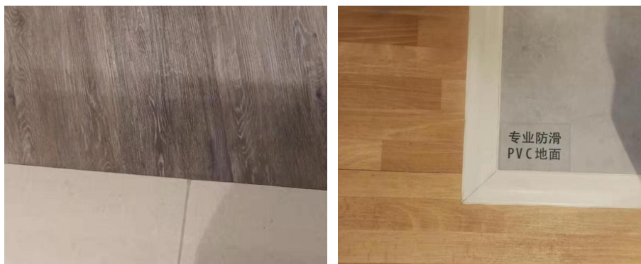
图 3.2.1-1 地砖与木地板、PVC 防滑铺装交接，图示两种材料摩擦系数相近
